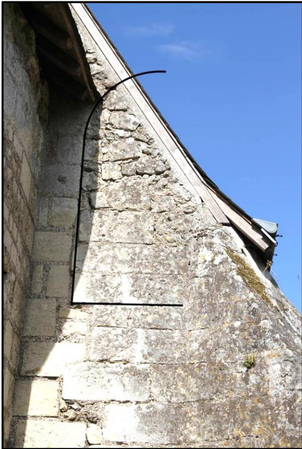
**Figure 160** La façade Est coté nord, les traces d'une ancienne baie sont visibles, (ici surlignée) démontrant que l'église fut réduite au Nord
